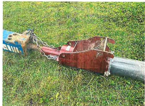
3 Fundamentrohr über das zu schlagende Loch positionieren
